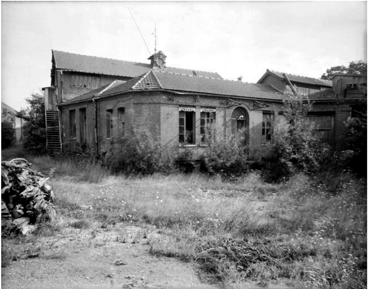
Atelier de fabrication, vue partielle en 1988.
