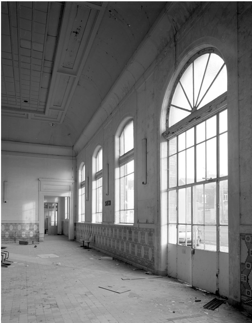
Entrée de la salle des pas perdus et couloir menant vers les bureaux de la douane.
