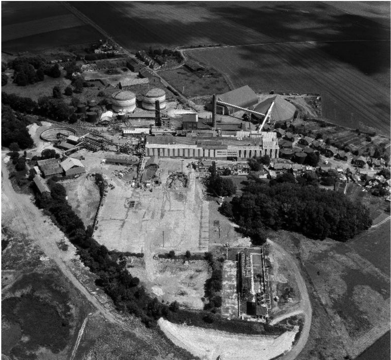
Vue aérienne, flanc ouest.
