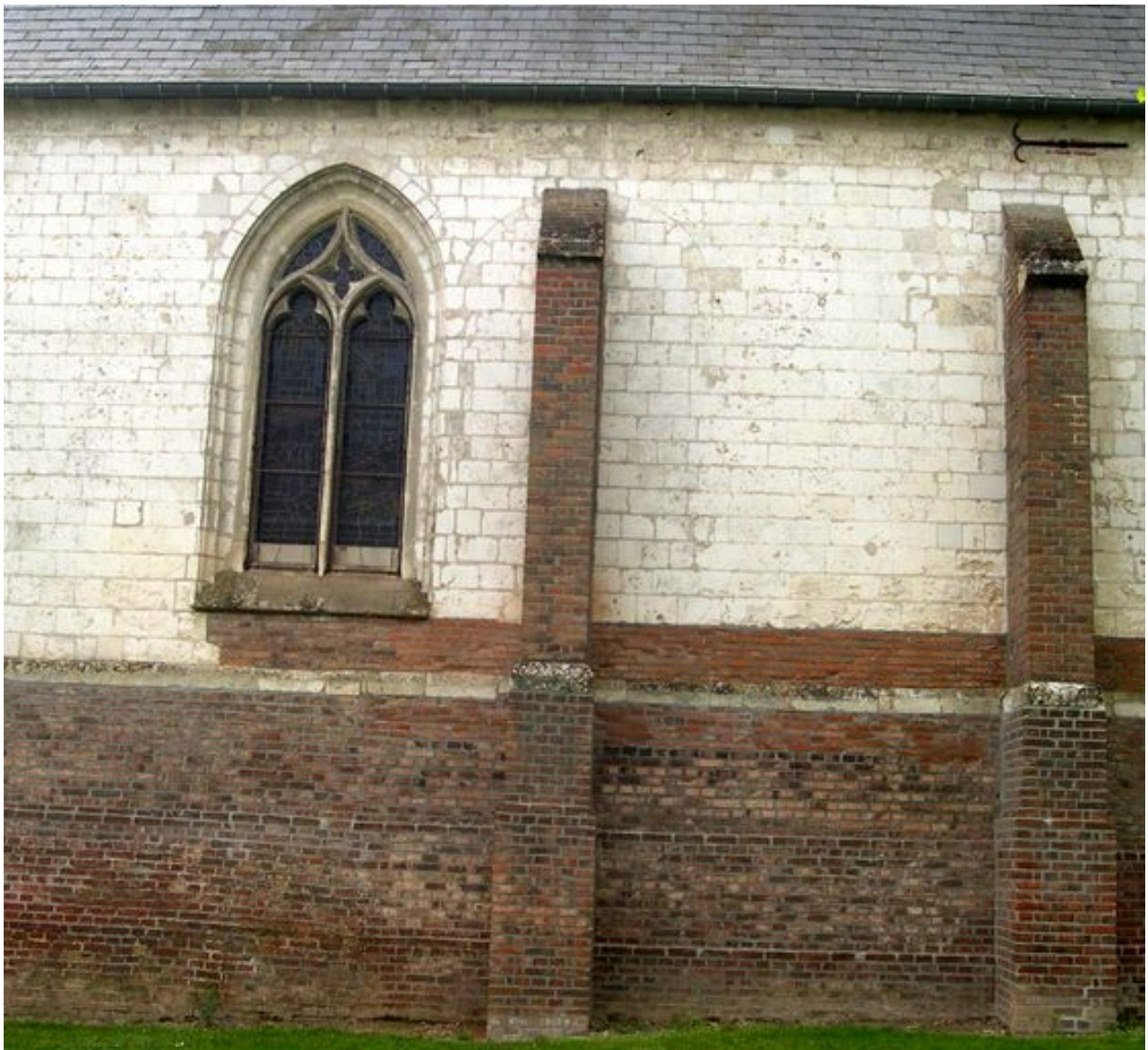
Baie murée du mur nord.
