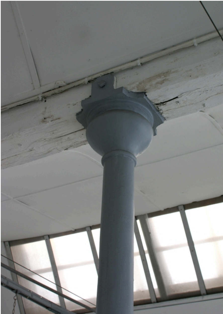
Ateliers antérieurs à 1900 (ensemble ouest) : chapiteau d'une colonne en fonte de l'étage.
