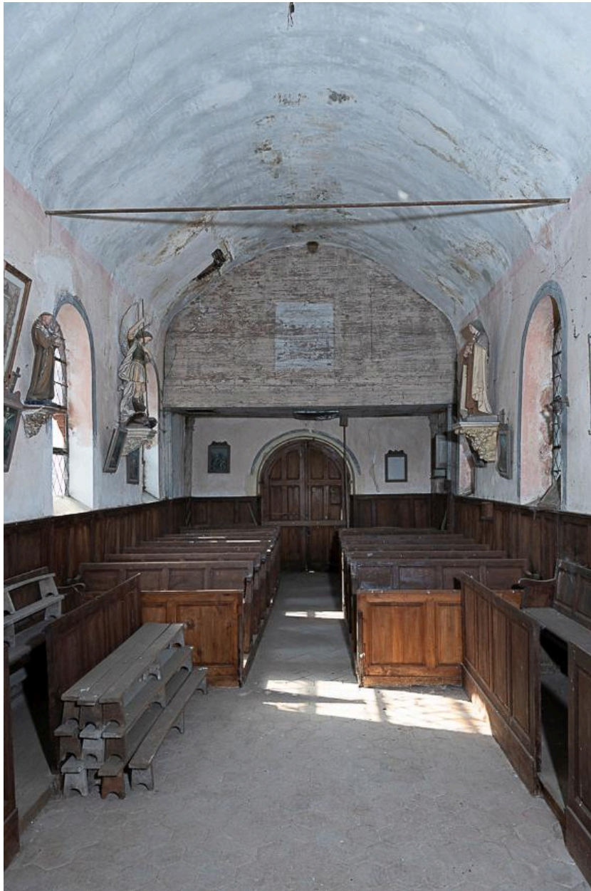
Vue générale vers la nef.
