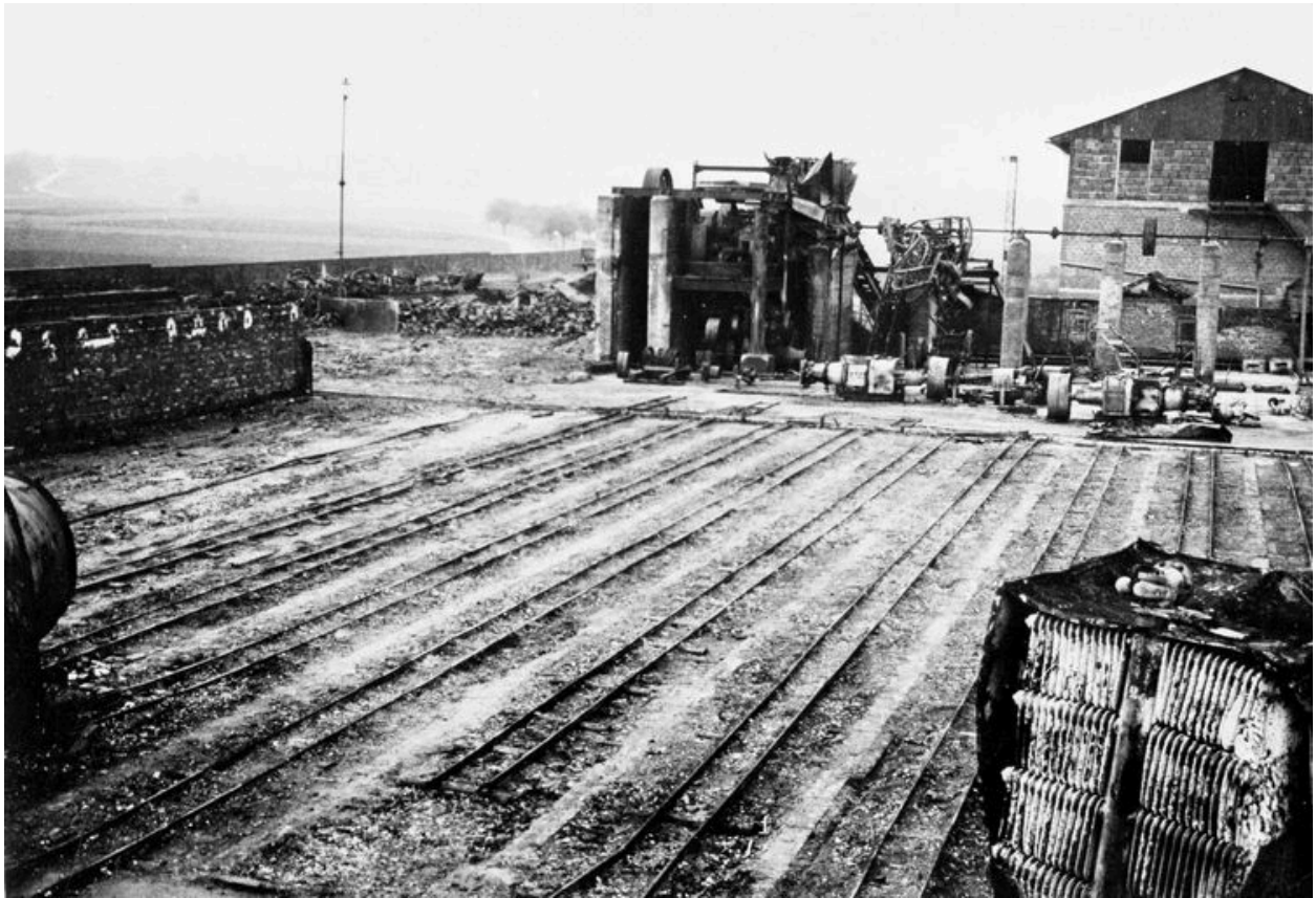
REMY. Briqueterie Bohy. Vestiges des rails de séchage des briques après l'incendie du 19 septembre 1934 (AP).
