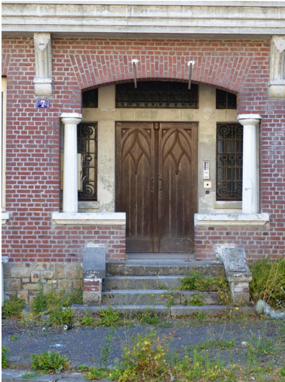
Vue de détail sur le porche dans oeuvre.
