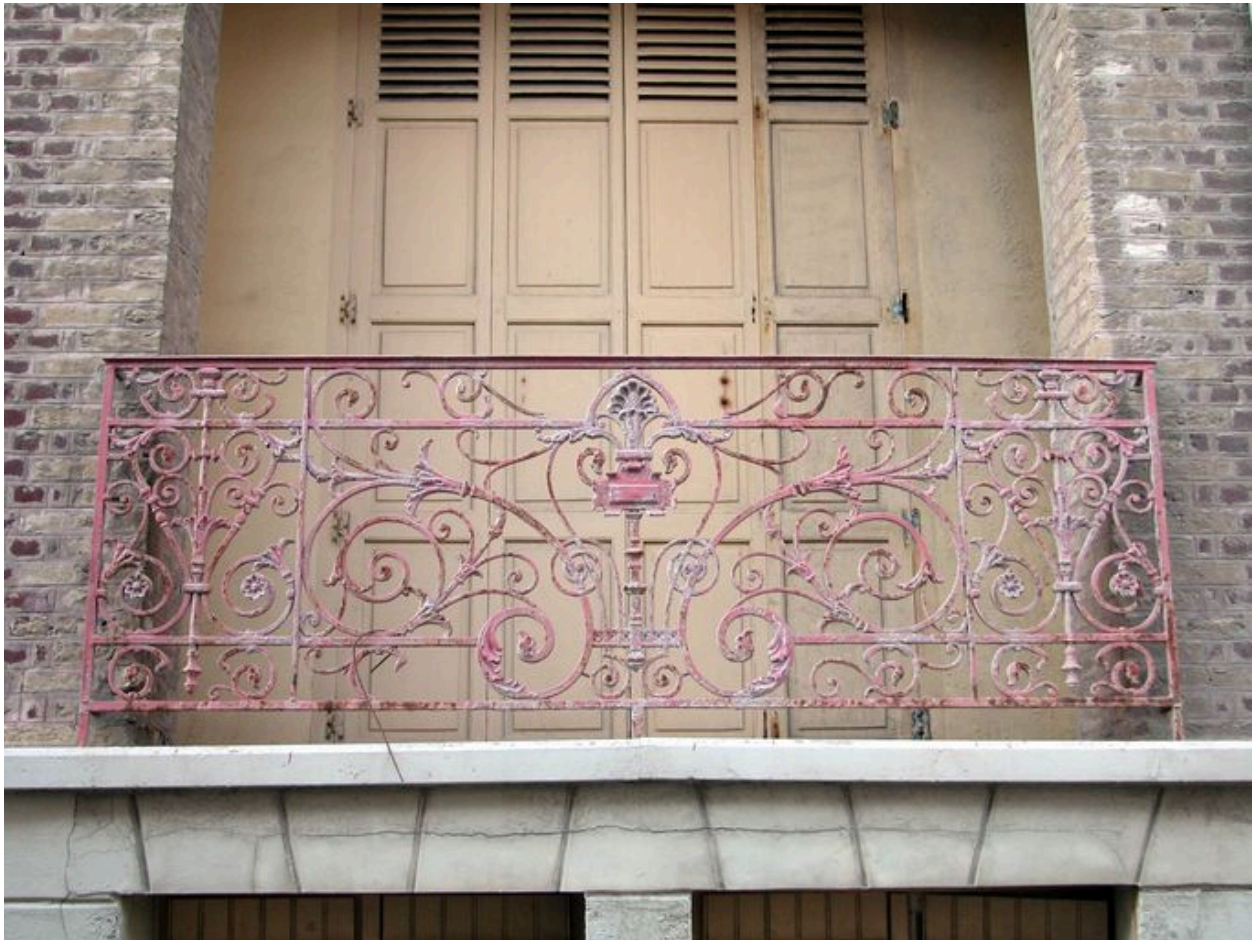
Détail du balcon en ferronnerie de la maison dite Beauregard.
