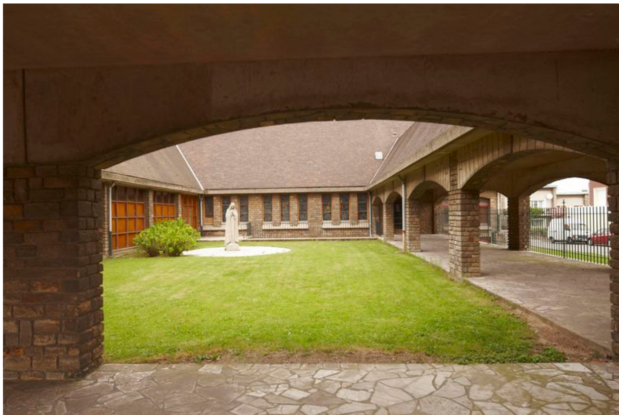
Vue des galeries.
