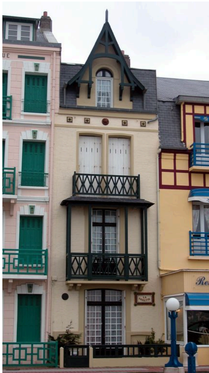
Vue d'ensemble depuis l'esplanade.
