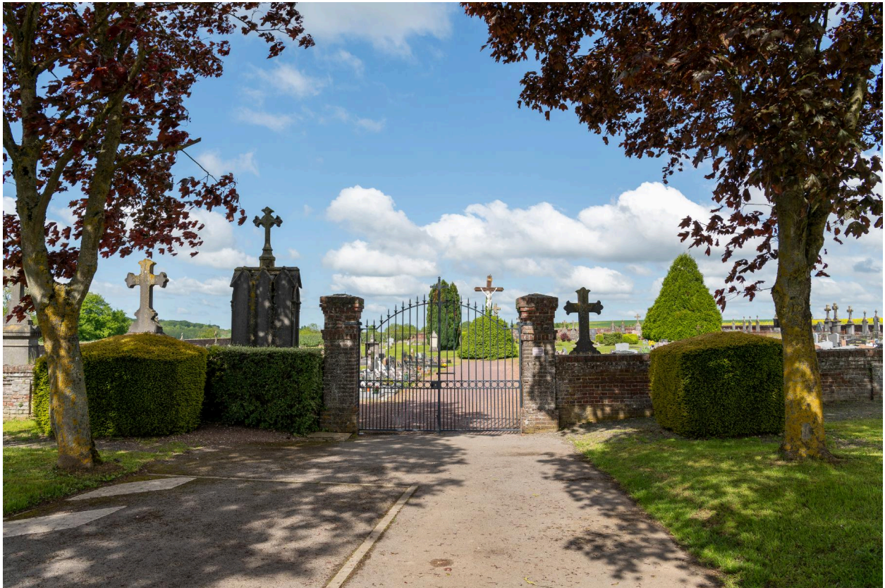
Vue générale de l'entrée du cimetière.
