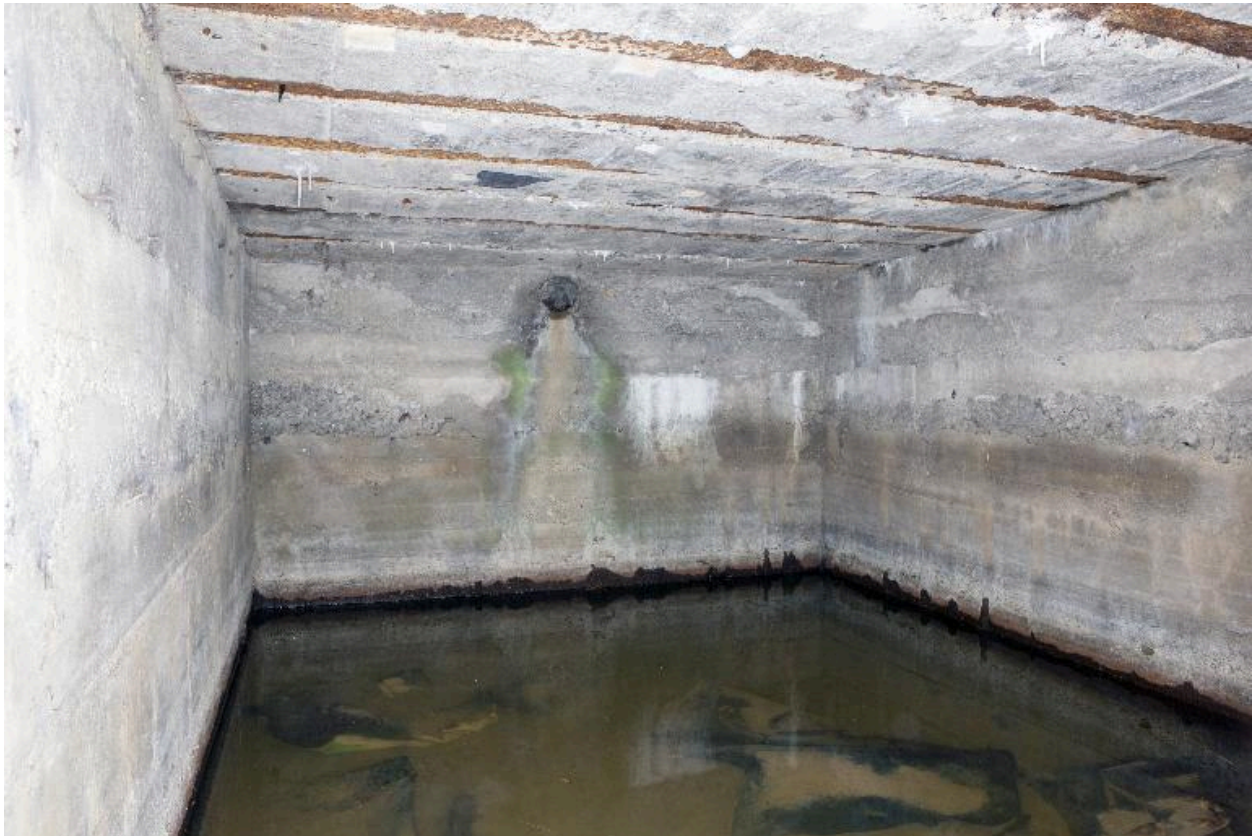
Vue intérieure de l'unique salle, vers le nord
