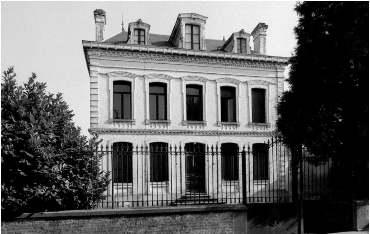
Vue d'ensemble de la façade.
