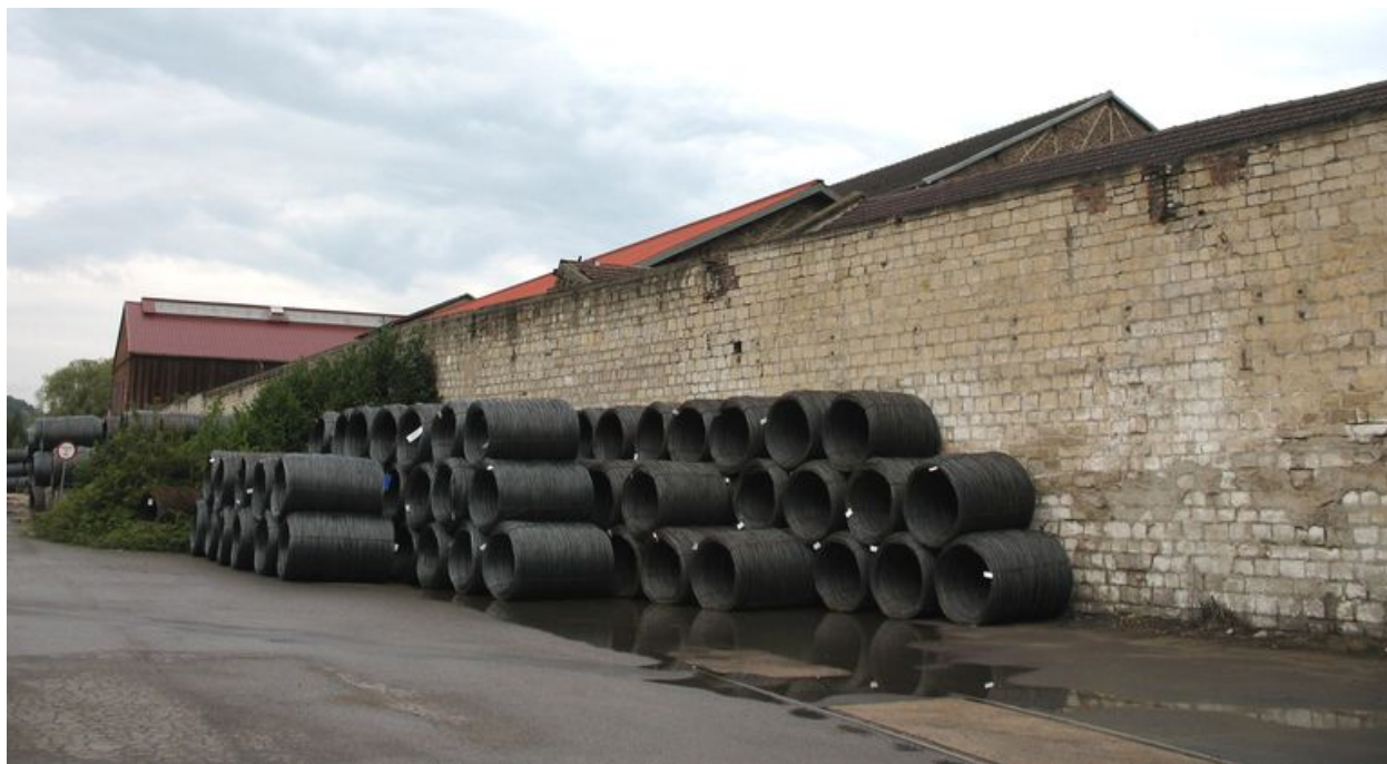
Mur de clôture de la fonderie.
