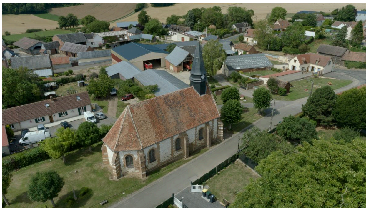
Vue aérienne de l'église depuis le nord-est.
