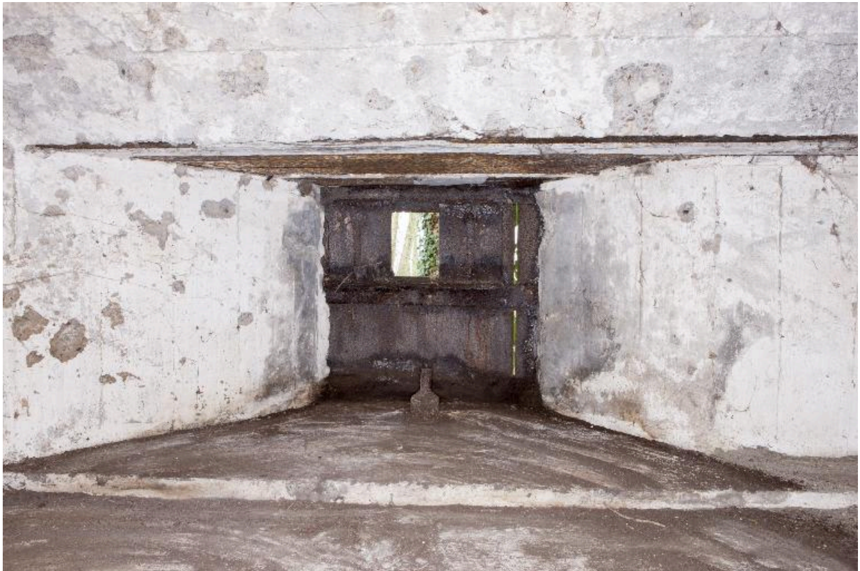
Détail du créneau de fusillage depuis la table de la mitrailleuse au premier niveau de l'édifice
