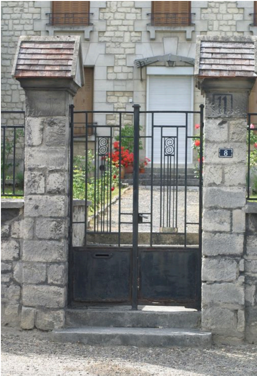
Détail du grillage de protection.
