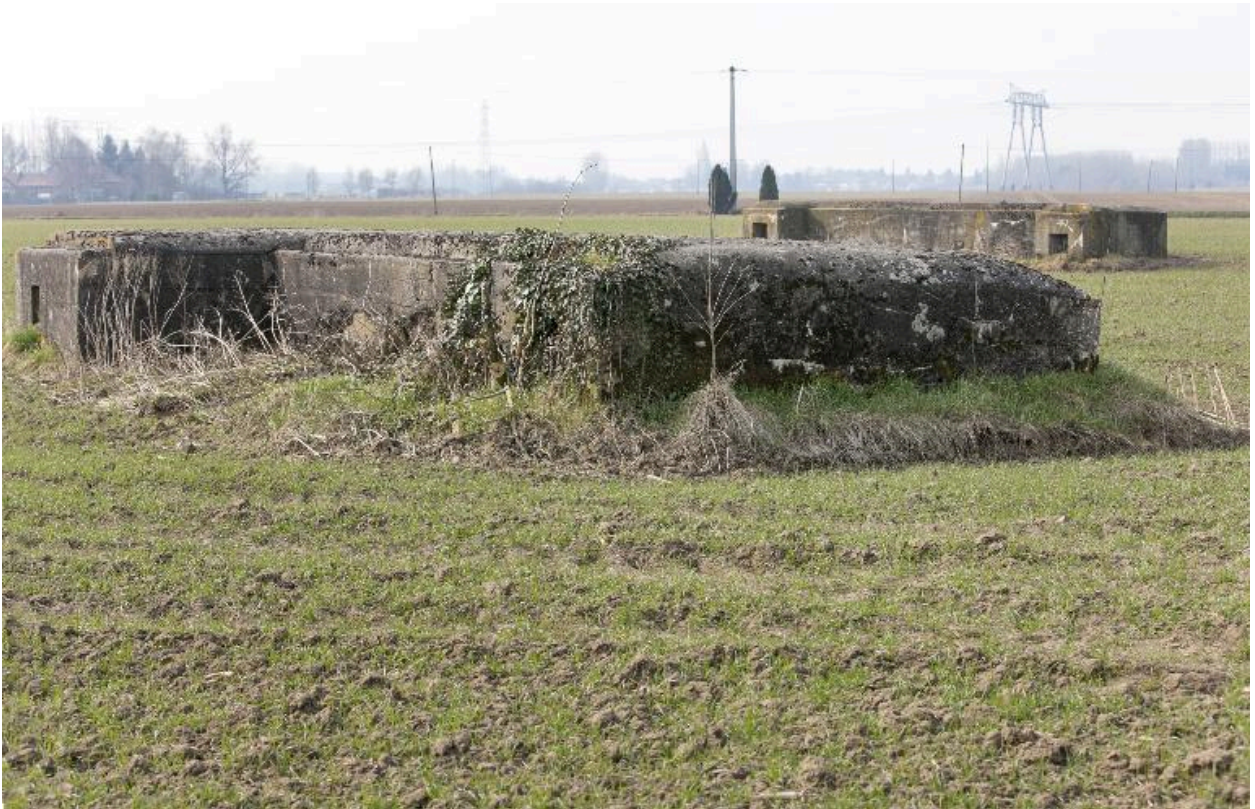
Ouvrage en L
