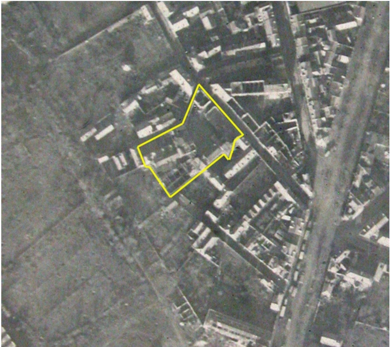
Vue aérienne du site en novembre 1911 (AD Aisne).
