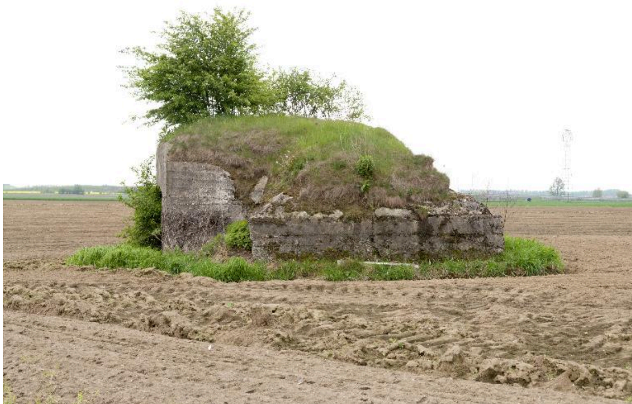
Vue latérale vers le sud
