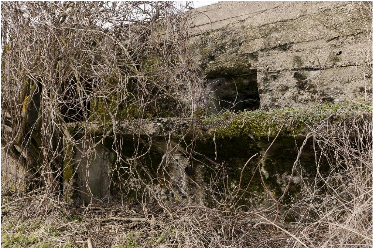
Entrée latérale sud-ouest, à gauche. Banquette de tir et niche à munitions
