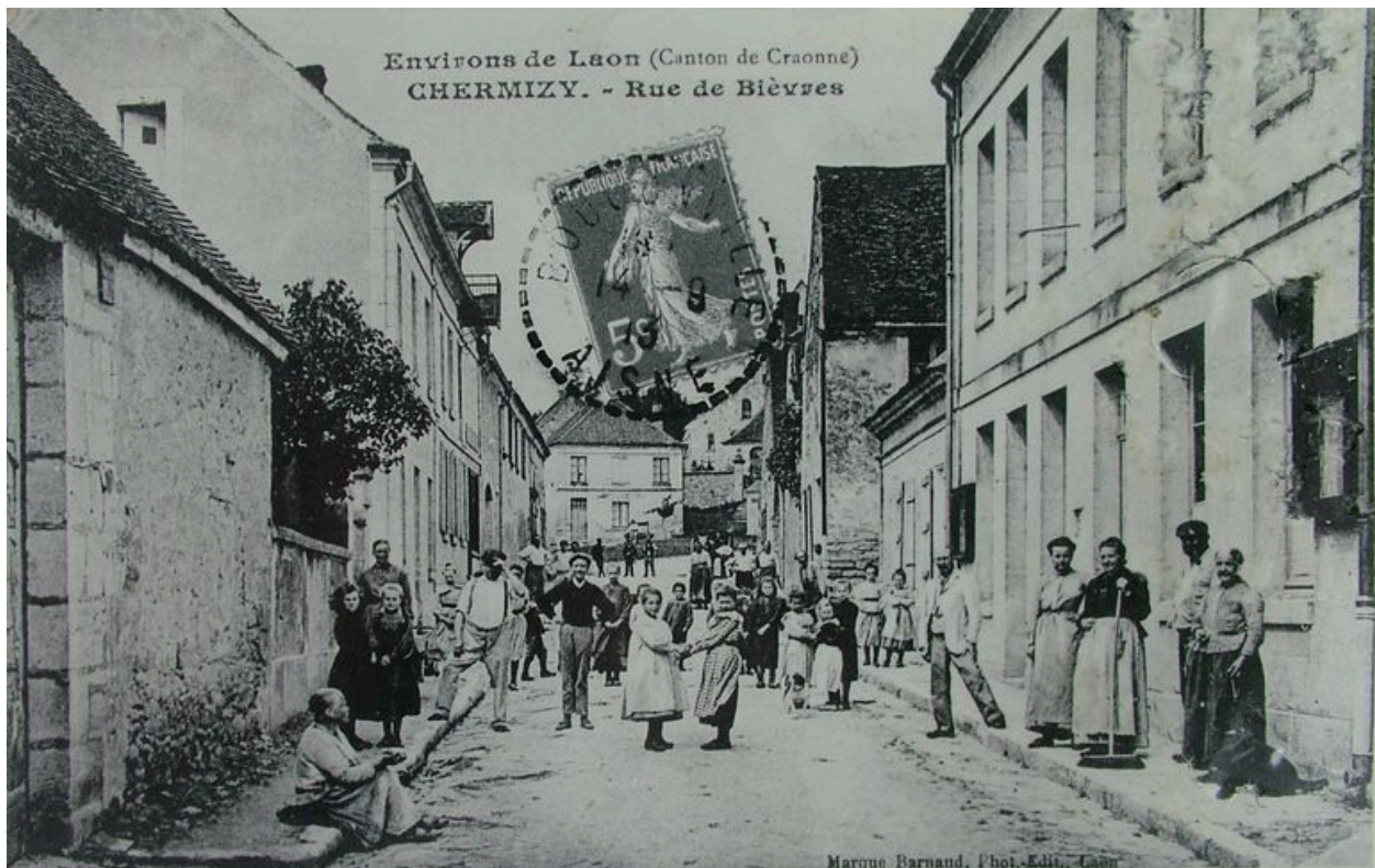
Vue ancienne d'une rue de Chermizy (coll. part).
