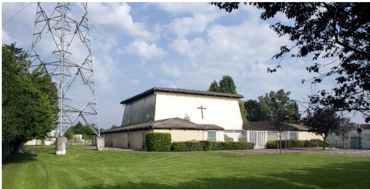
Vue de trois-quart, avant gauche de l'église.
