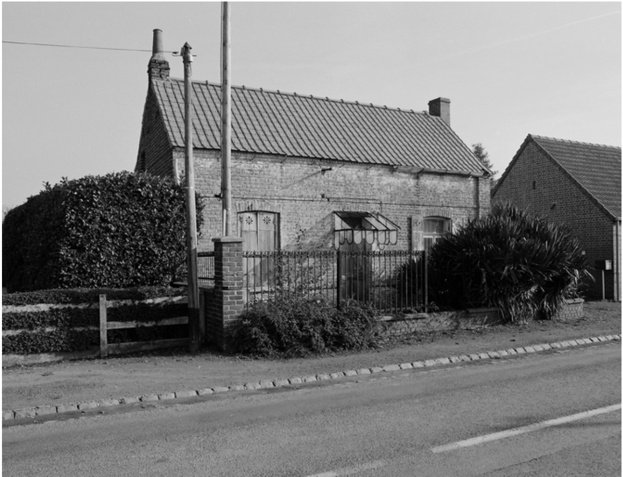
Maison élémentaire, 1059, rue de Lelier.
