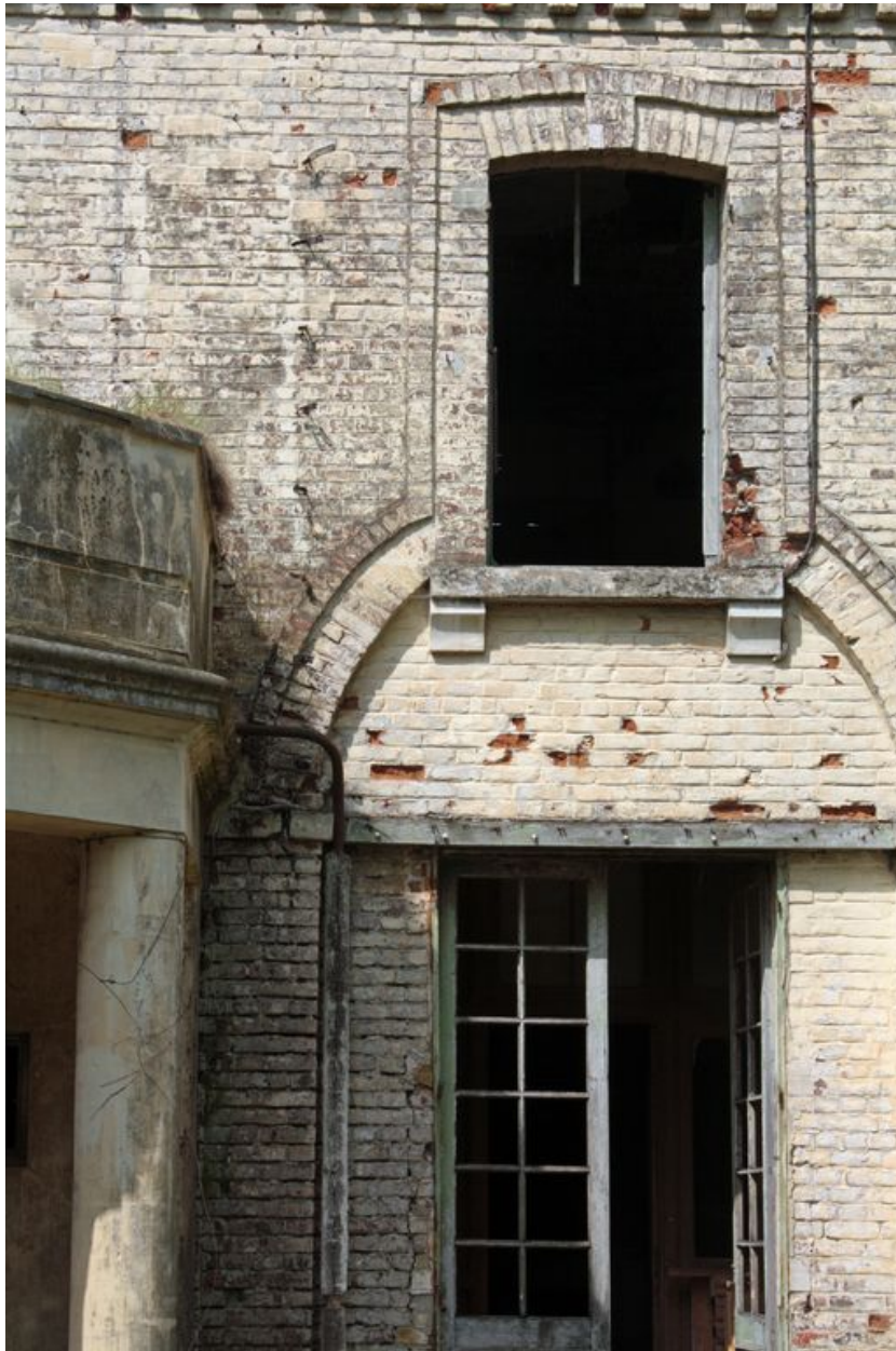
Détail des reprises d'ouvertures sur la façade sud, sur cour, du logement patronal.
