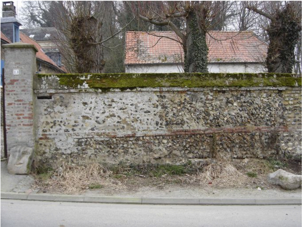
Vue partielle du mur de clôture.
