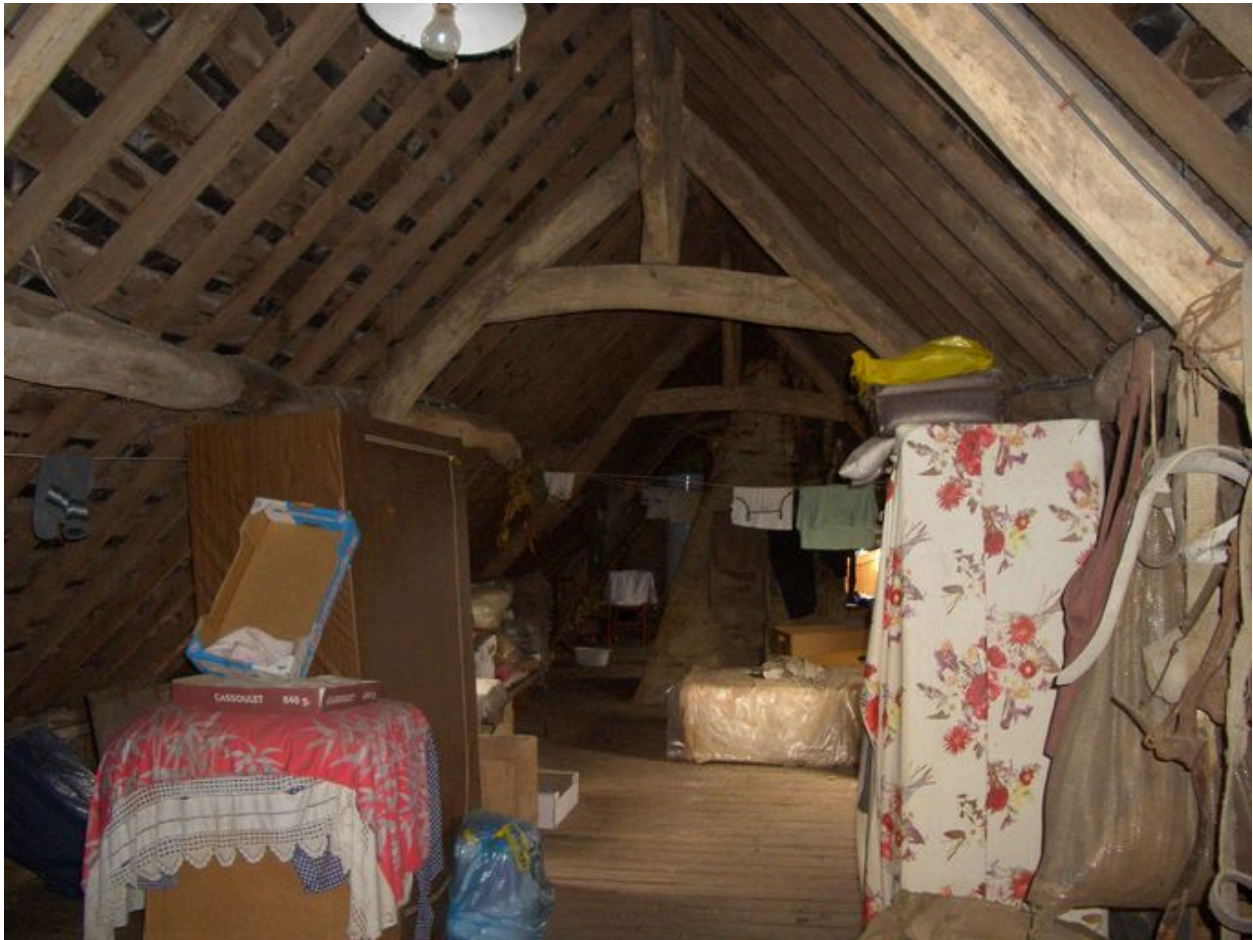
Vue générale du grenier.
