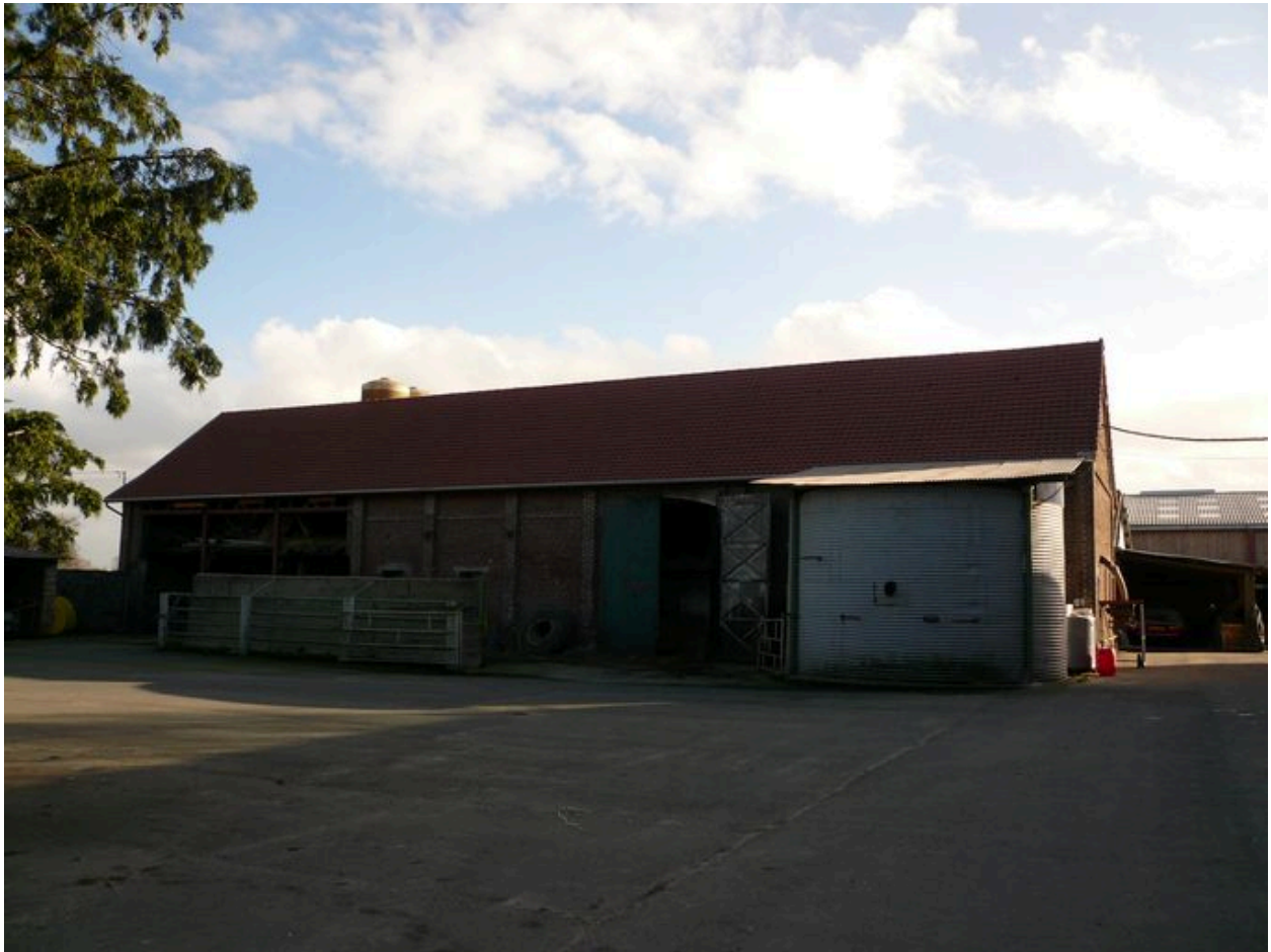
Vue de la grange au sud.
