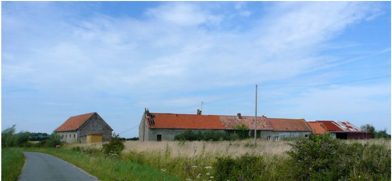
Vue générale (depuis le sud-ouest).
