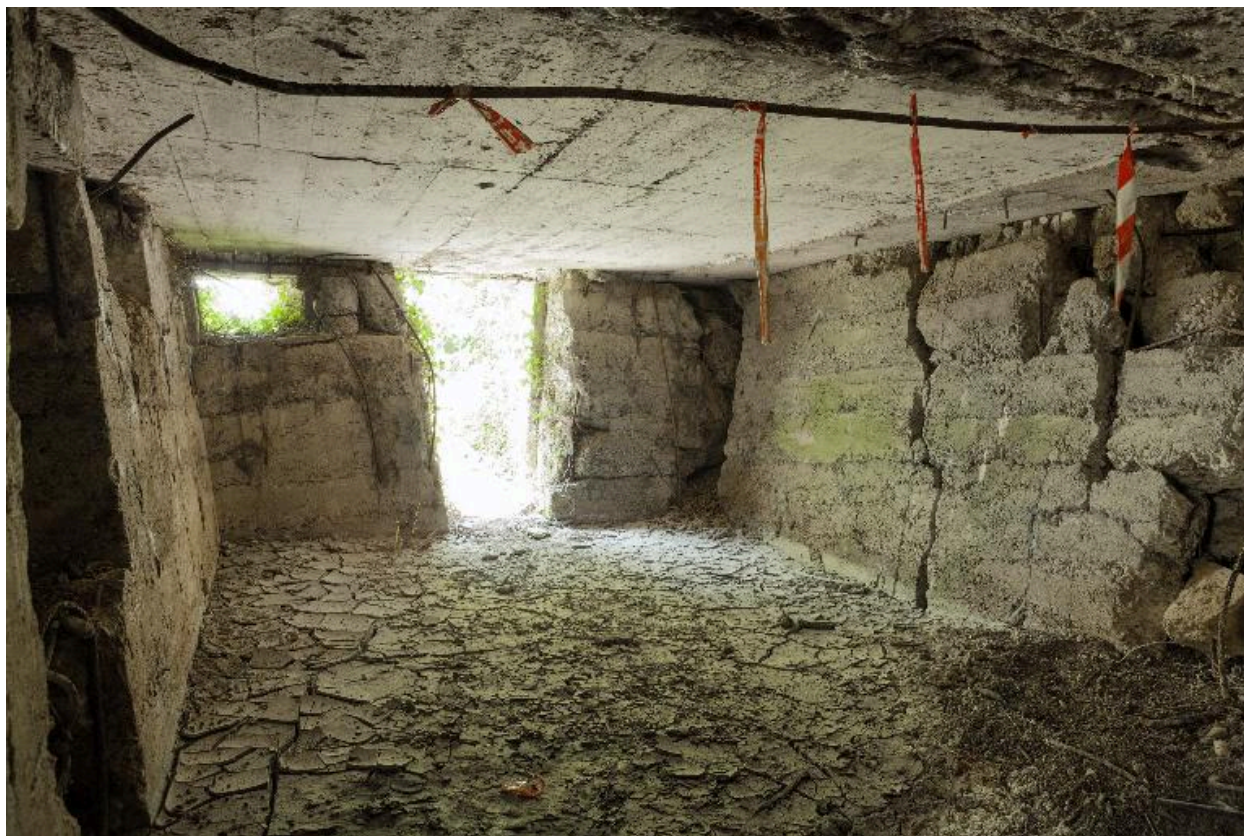
Vue intérieure vers la sortie sud
