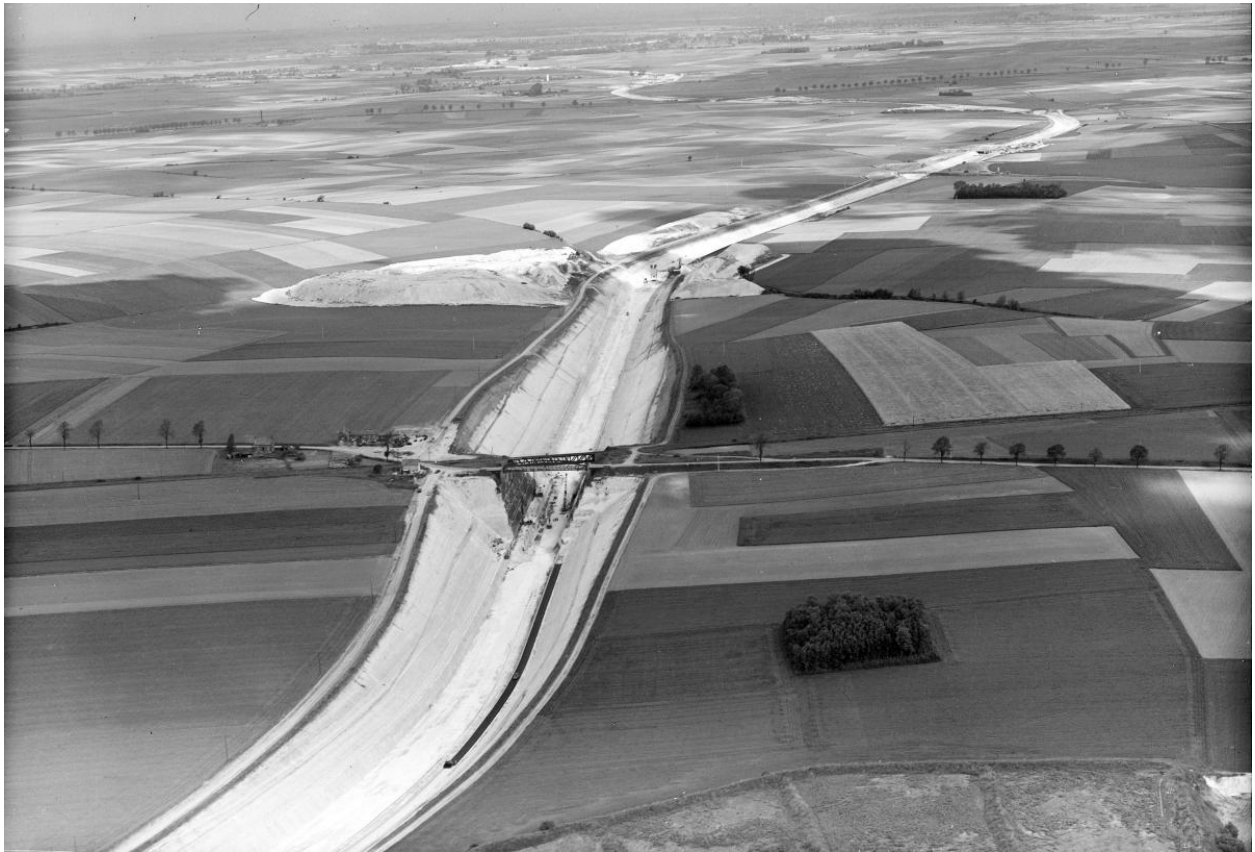
Chantier de finalisation de la grande tranchée d'Havrincourt. Vue arienne depuis le sud. 1965. Source : IGN, Photothèque Nationale.
