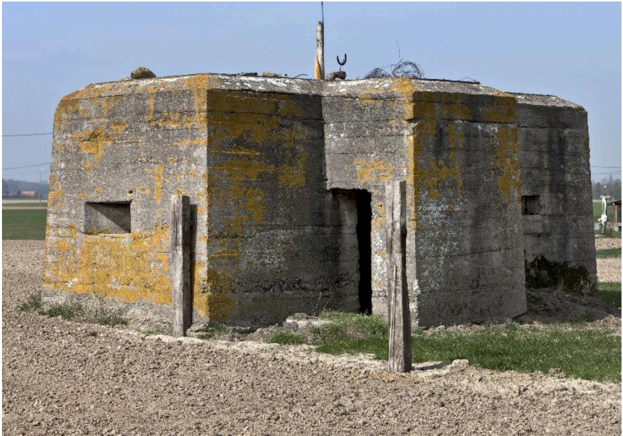
Vue vers le nord-ouest. L'entrée.
