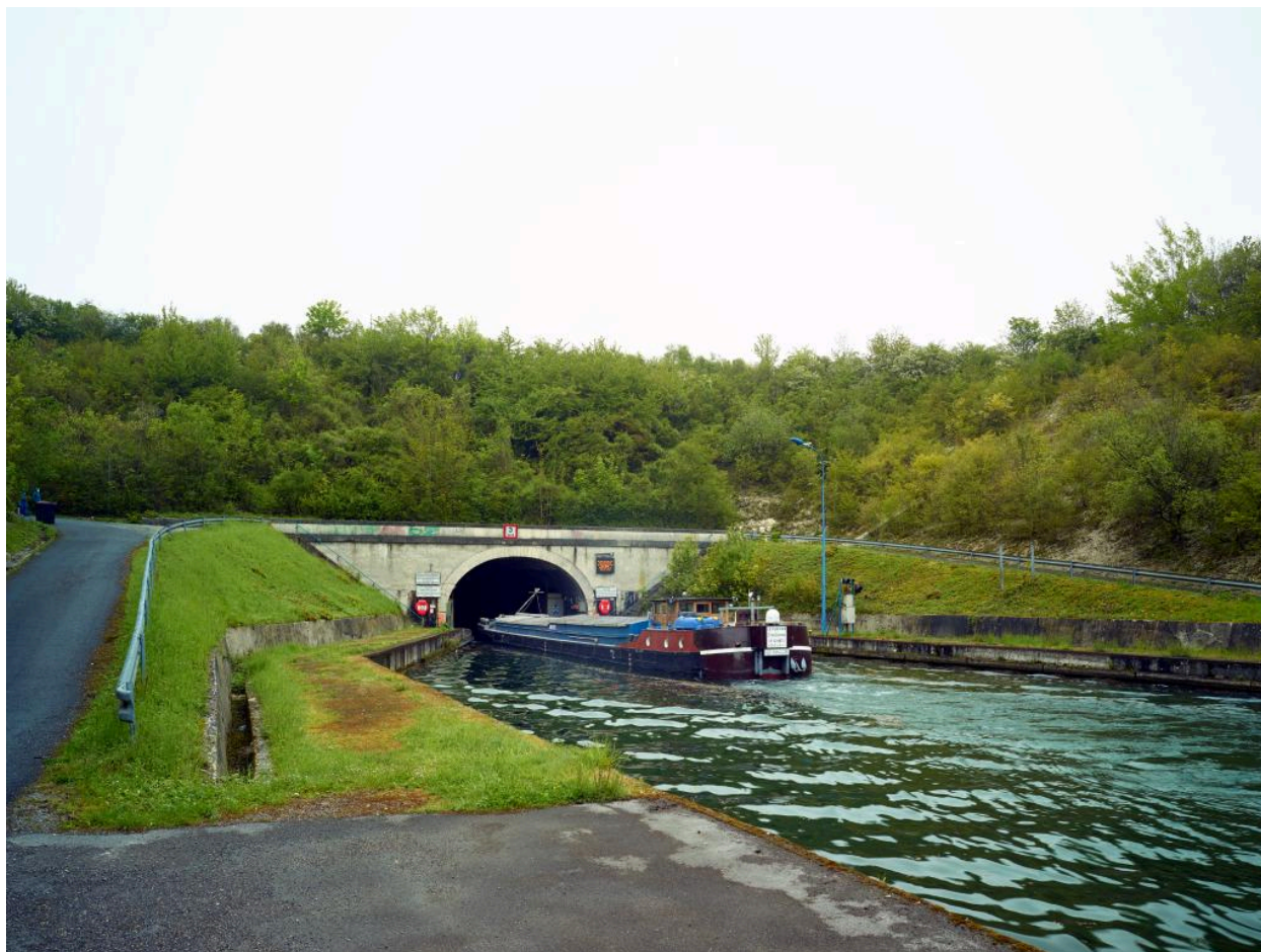
Tête nord, voie de circulation et quai de stationnement pour les péniches.
