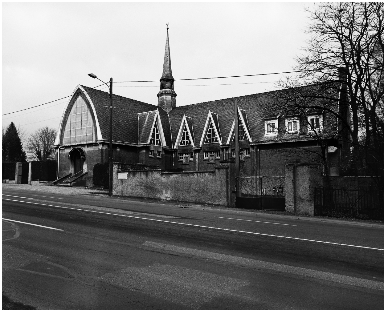
Vue générale du couvent depuis la rue.
