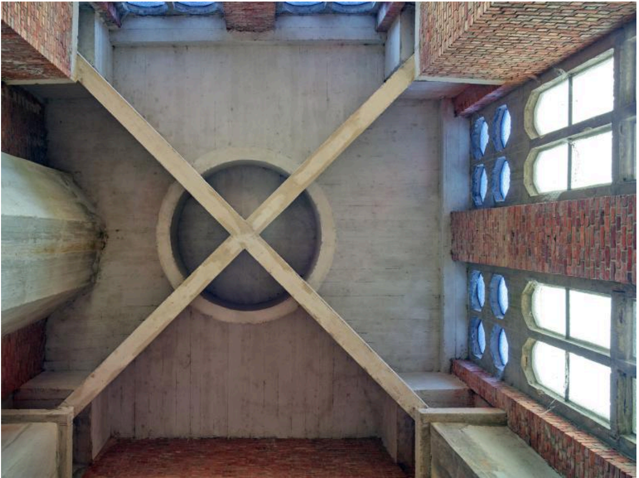
Vue zénithale de l'intérieur du clocher. Structure supportant le campanile.
