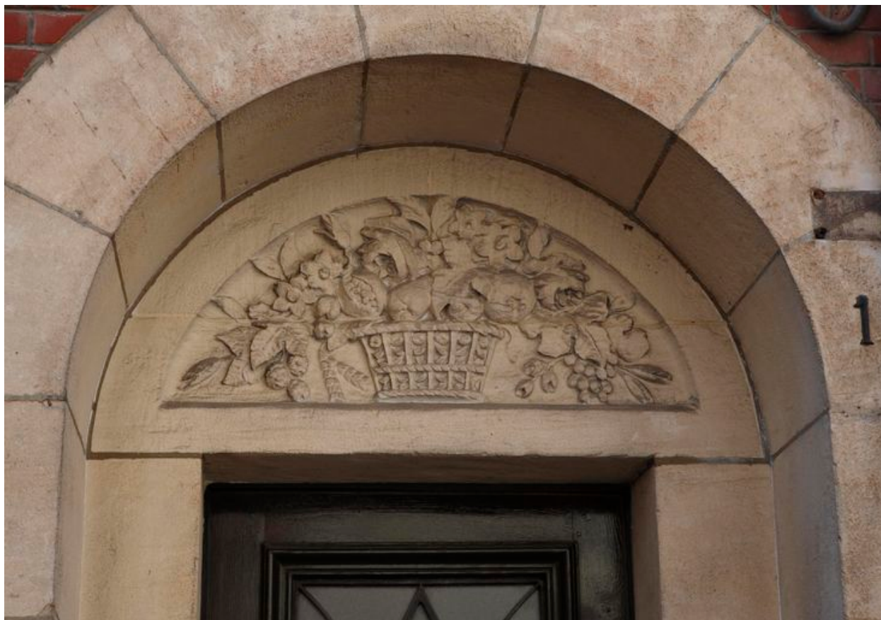
Couronnement Art déco de la porte d'entrée.
