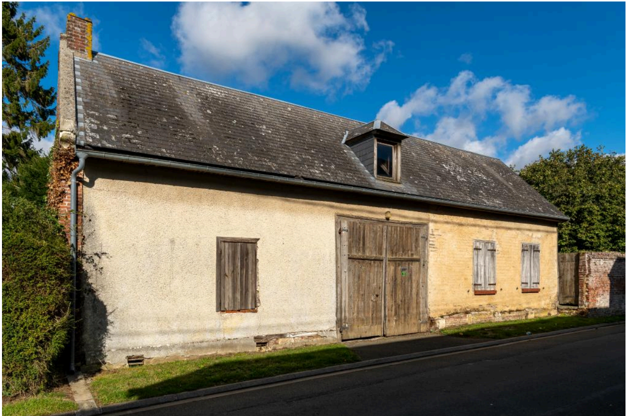
Grange et ancien atelier sur rue, n°3 rue Neuve, vue depuis le sud.
