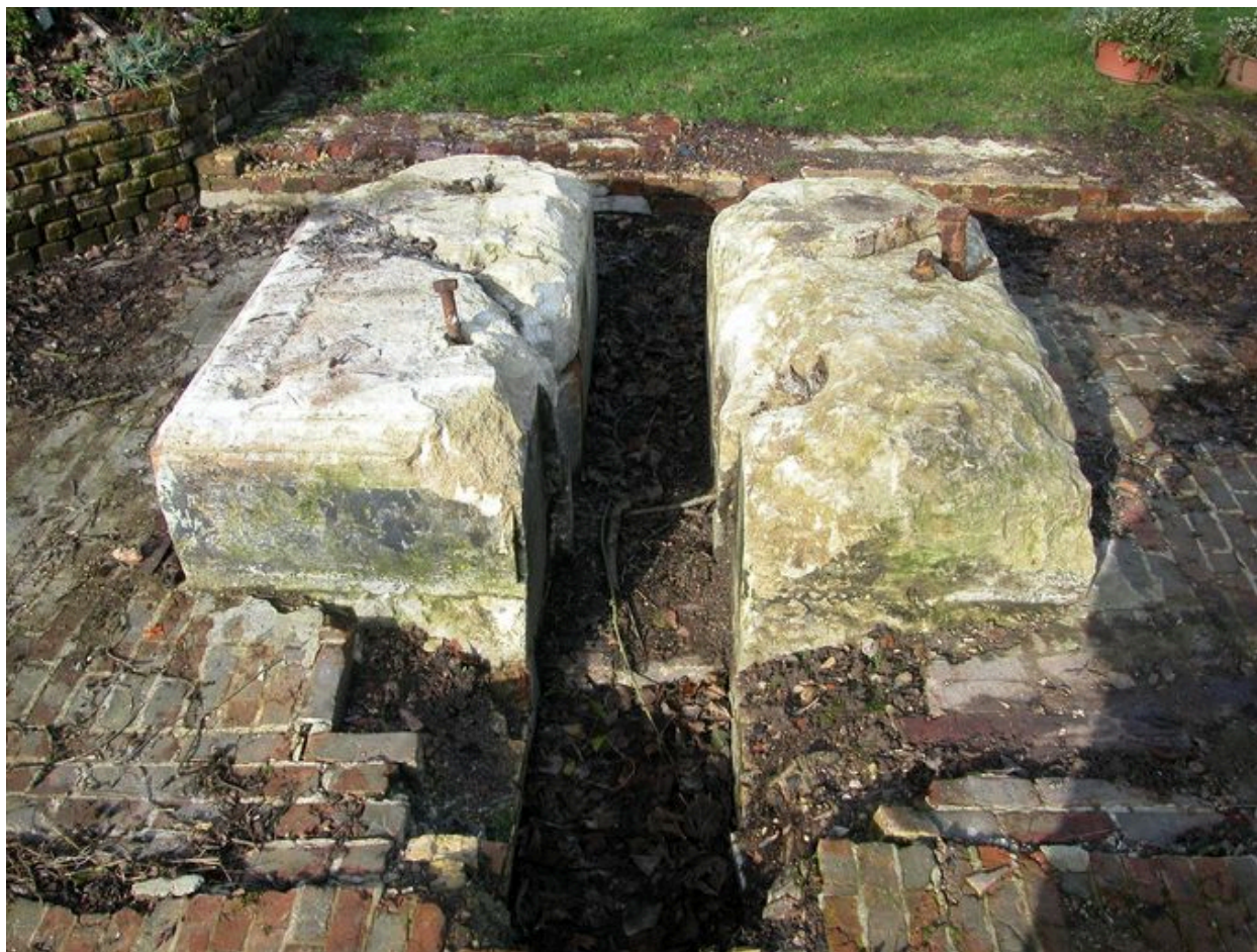
Détail du socle en pierre de la machine à vapeur.
