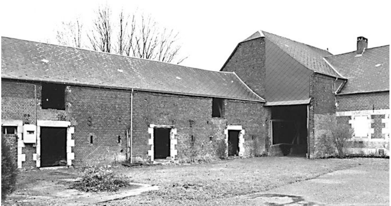
Etables à vache et chevaux, grange traversante attenante au logis.
