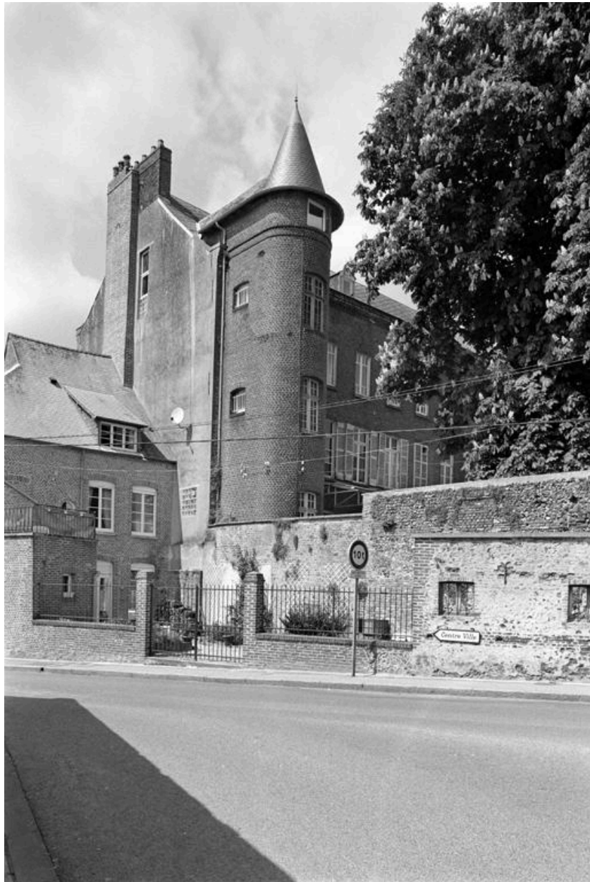
Vue de l'escalier hors-oeuvre, élevé sur la façade postérieure.
