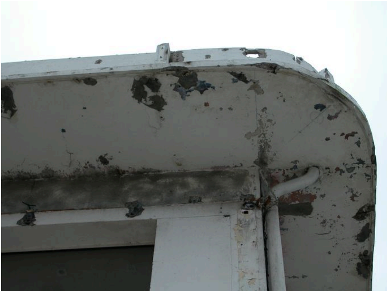
Détail de la corniche de la façade antérieure.
