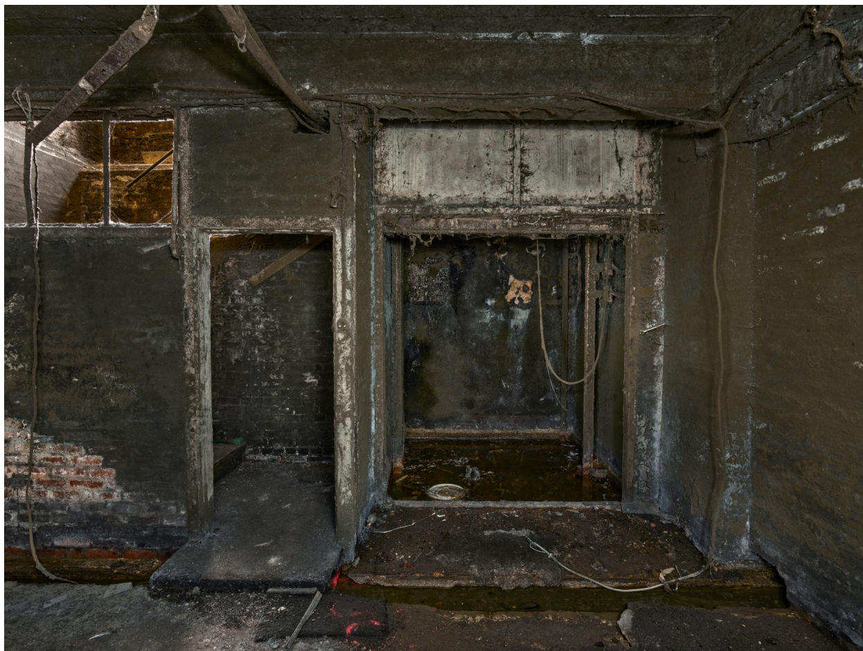
Bâtiment A, monte-charge depuis le sous-sol.
