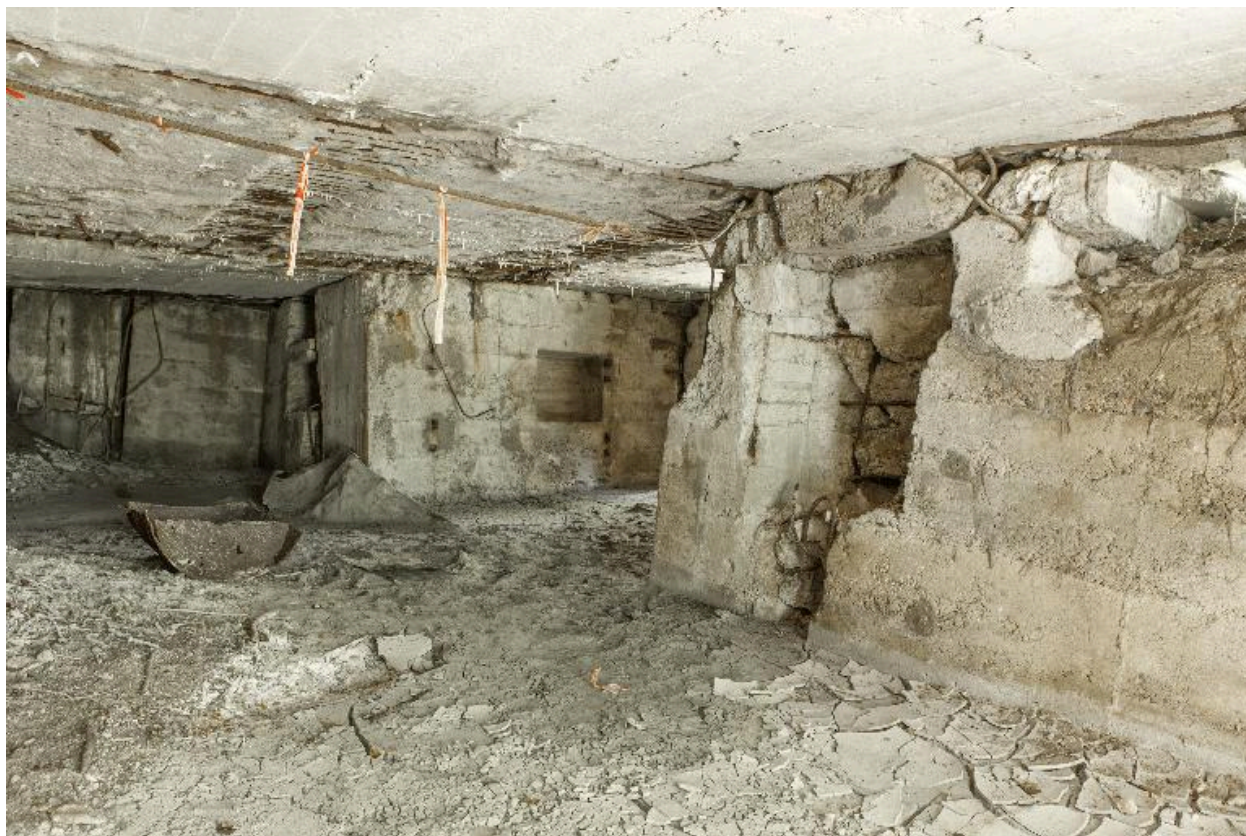
Vue intérieure depuis l'entrée sud
