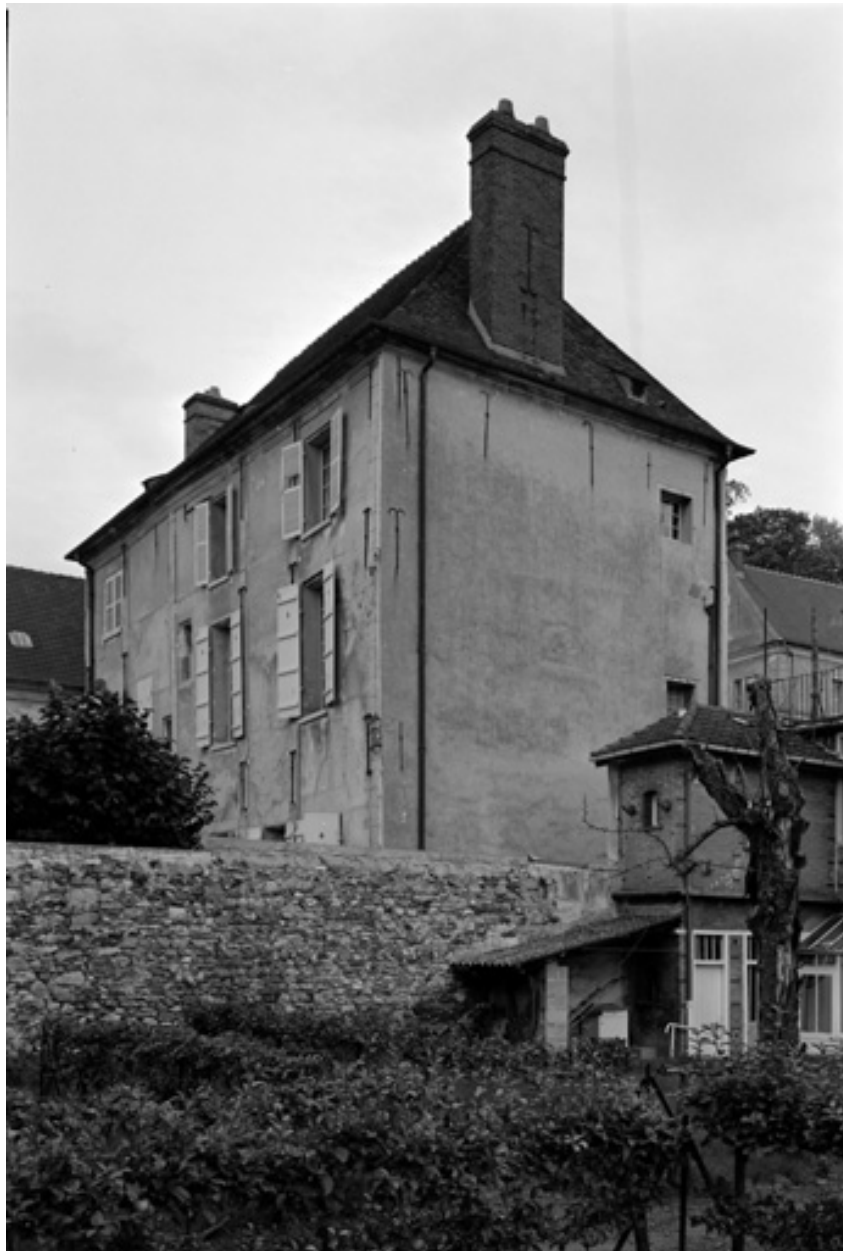
Vue du pignon sud depuis le jardin du n° 10.
