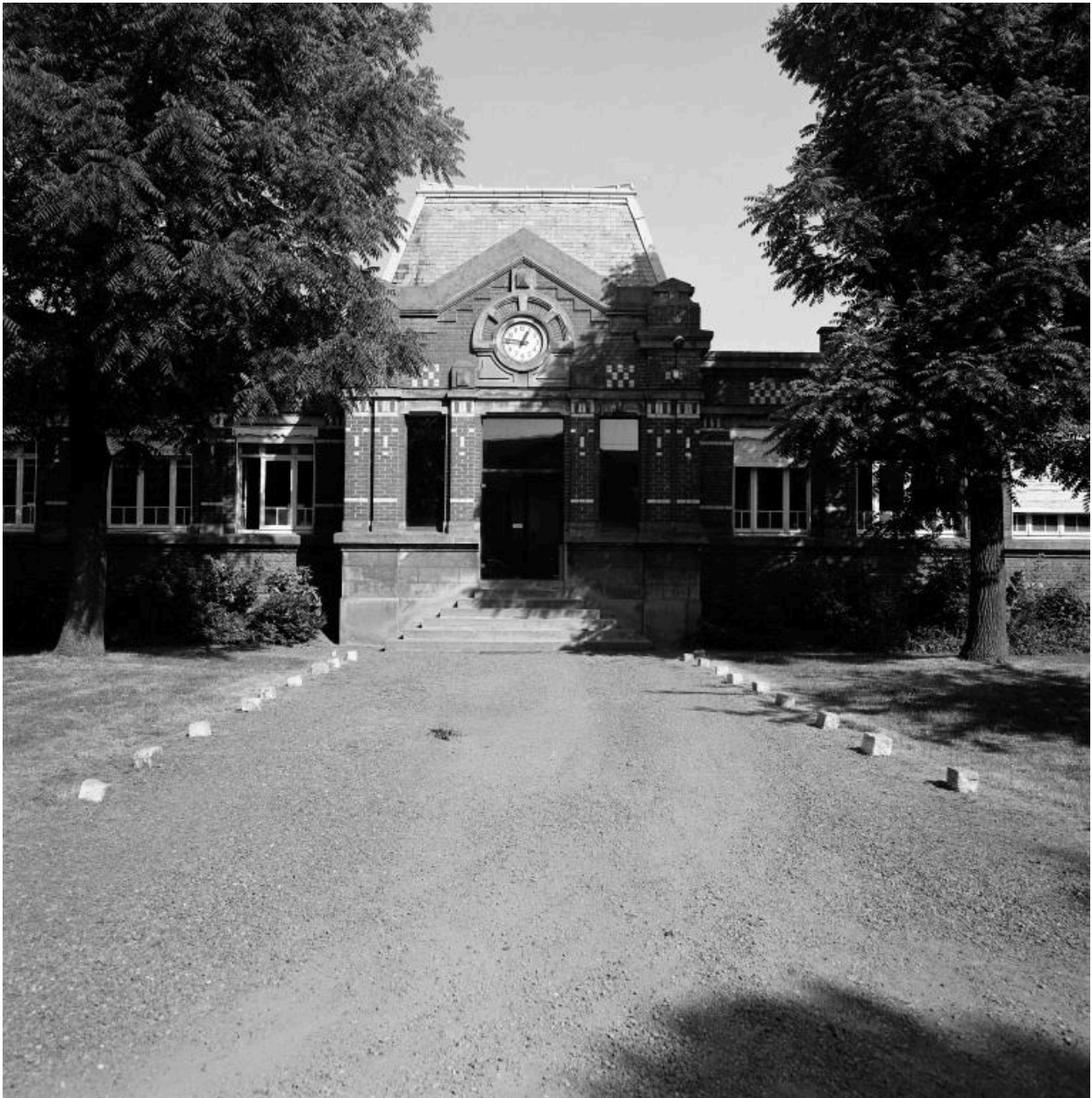
Bureaux vus depuis l'entrée. Corps central.
