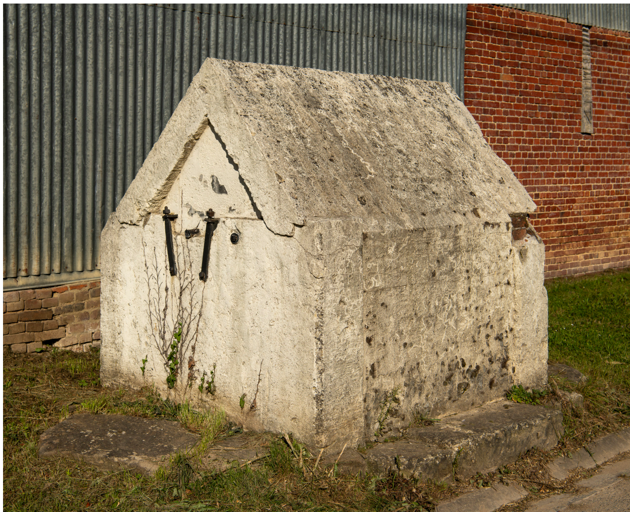
Ancien puits, rue de Plainville.
