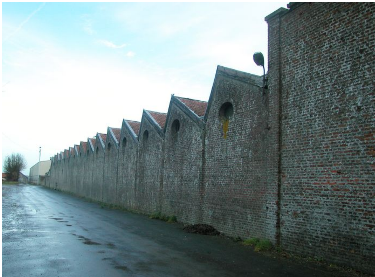
Façade sur rue des ateliers de fabrication.
