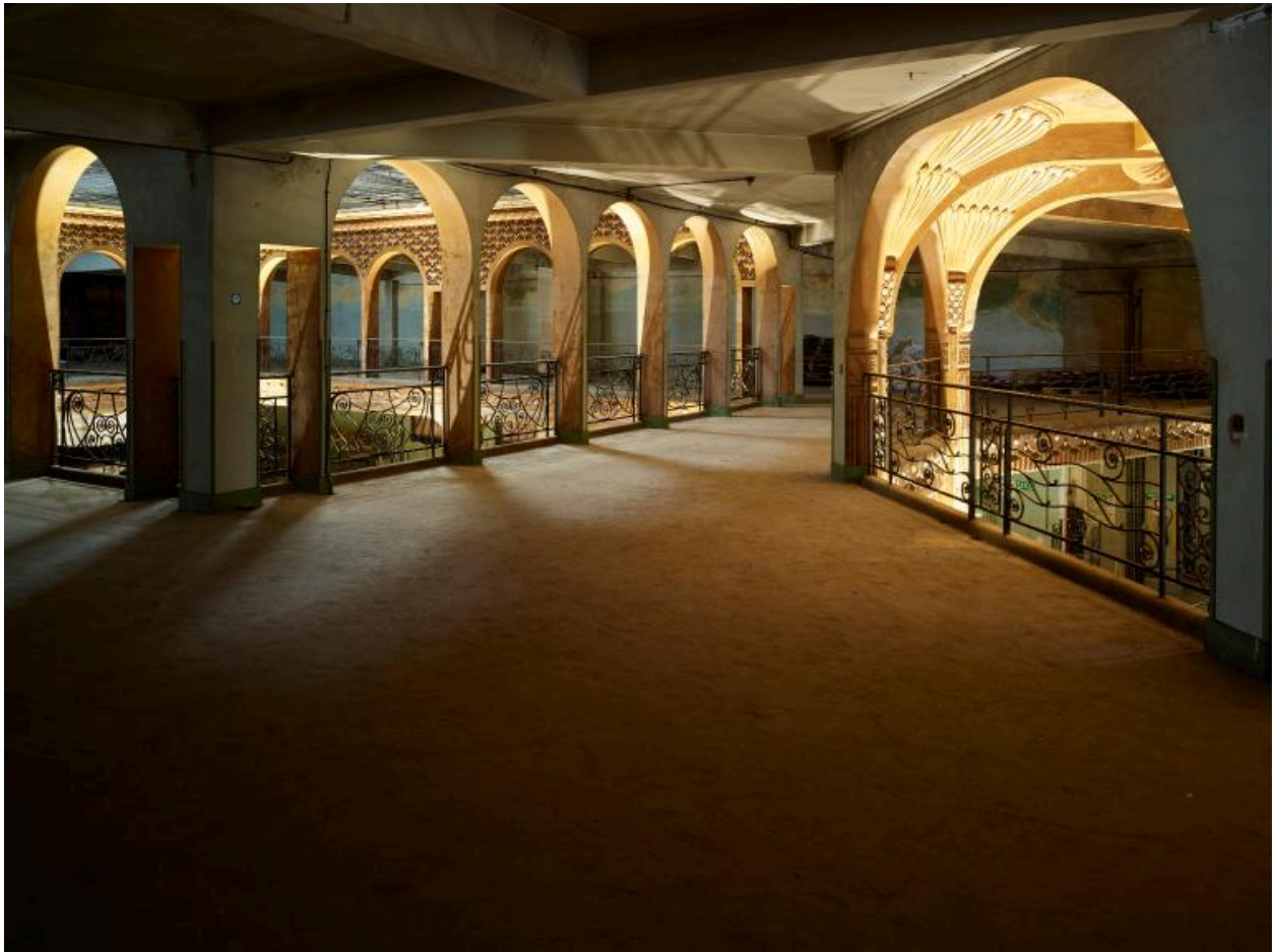
Espace de circulation du second étage, entre les deux atriums.
