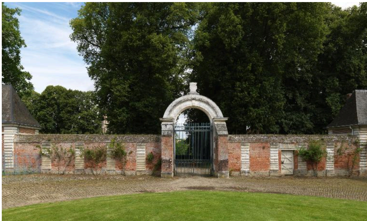
Revers du mur de clôture de la cour et du portail principal.
